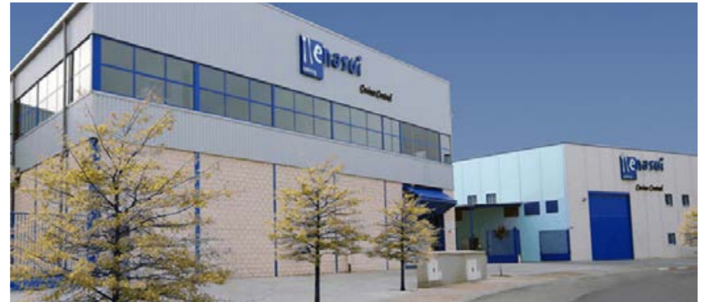
Instalaciones donde se ubican las cocinas centrales de Enasui, S.L., en Arganda del Rey.
